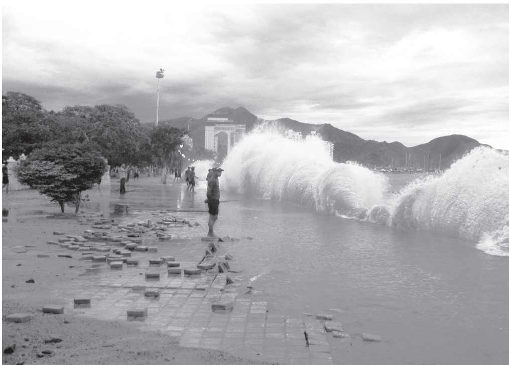
Figura 7. Daños estructurales sobre el malecón de la Bahía de Santa Marta, causados por el mar de leva el 24 de Octubre de 2012. Foto de David Morales.
